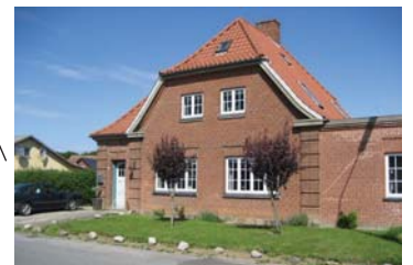
Den tidligere stationsbygning i Sjølund
